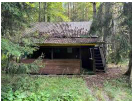
Būve (vasaras mājiņa) ar kadastra apzīmējumu 6280 001 0066 017
