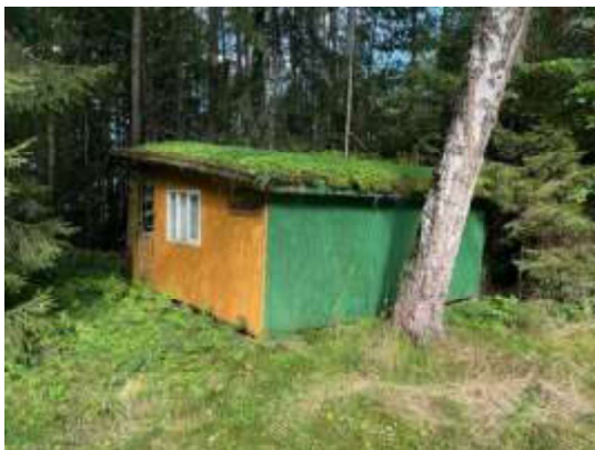
Būve (vasaras mājiņa) ar kadastra apzīmējumu 6280 001 0066 021
