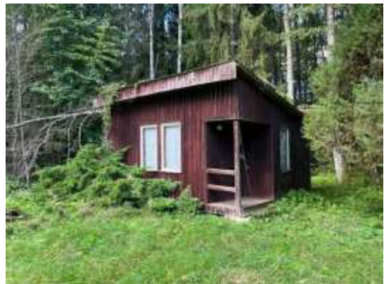
Būve (vasaras mājiņa) ar kadastra apzīmējumu 6280 001 0066 020
