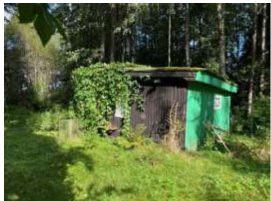
Būve (vasaras mājiņa) ar kadastra apzīmējumu 6280 001 0066 022
