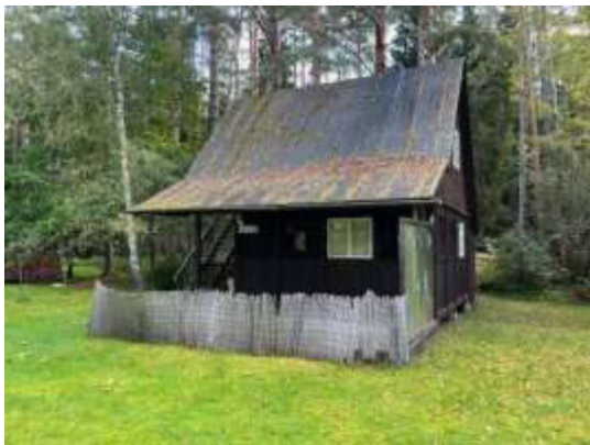
Būve (vasaras mājiņa) ar kadastra apzīmējumu 6280 001 0066 019
