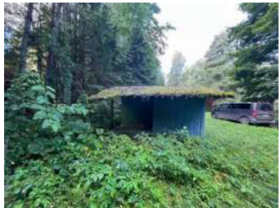
Būve (vasaras mājiņa) ar kadastra apzīmējumu 6280 001 0066 016
