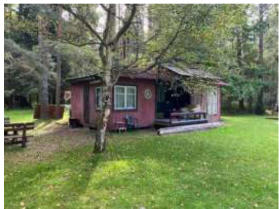
Būve (vasaras mājiņa) ar kadastra apzīmējumu 6280 001 0066 018
