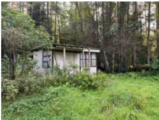
Būve (vasaras mājiņa) ar kadastra apzīmējumu 6280 001 0066 015
